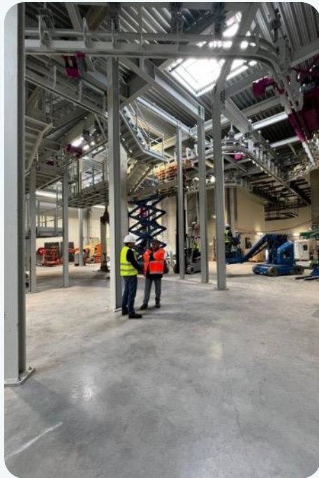
Site d'Henriville en construction en octobre 2024. Crédits photo : Le Républicain Lorrain.
